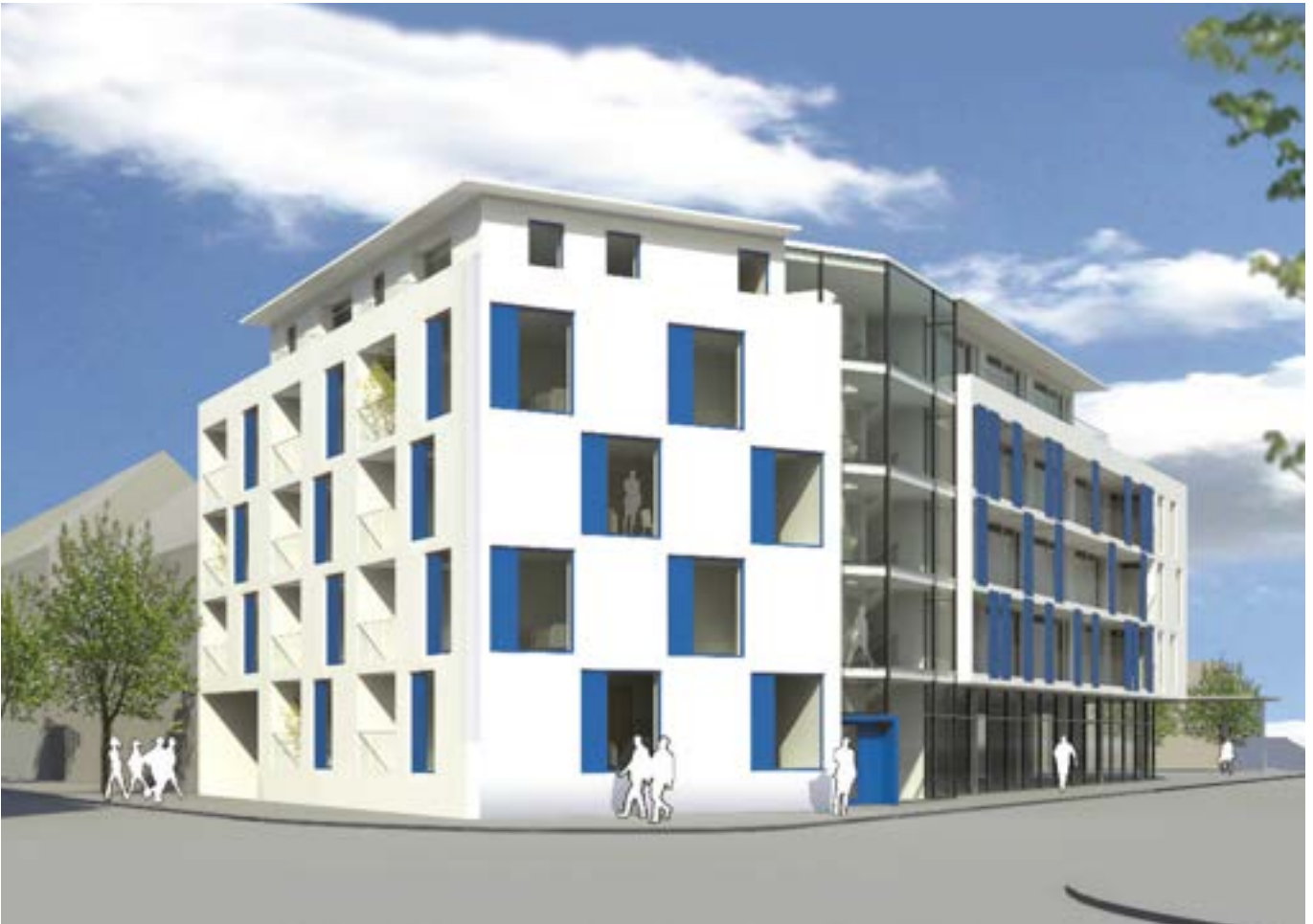
F-2 FERTIGSTELLUNG DER SENIORENGERECHTEN WOHNANLAGE IM FRÜHJAHR 2018
