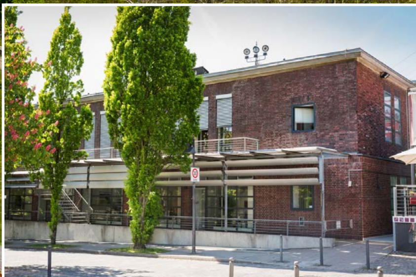
Die ehemalige Waschkaue bietet heute moderne Büro- und Nutzflächen.
