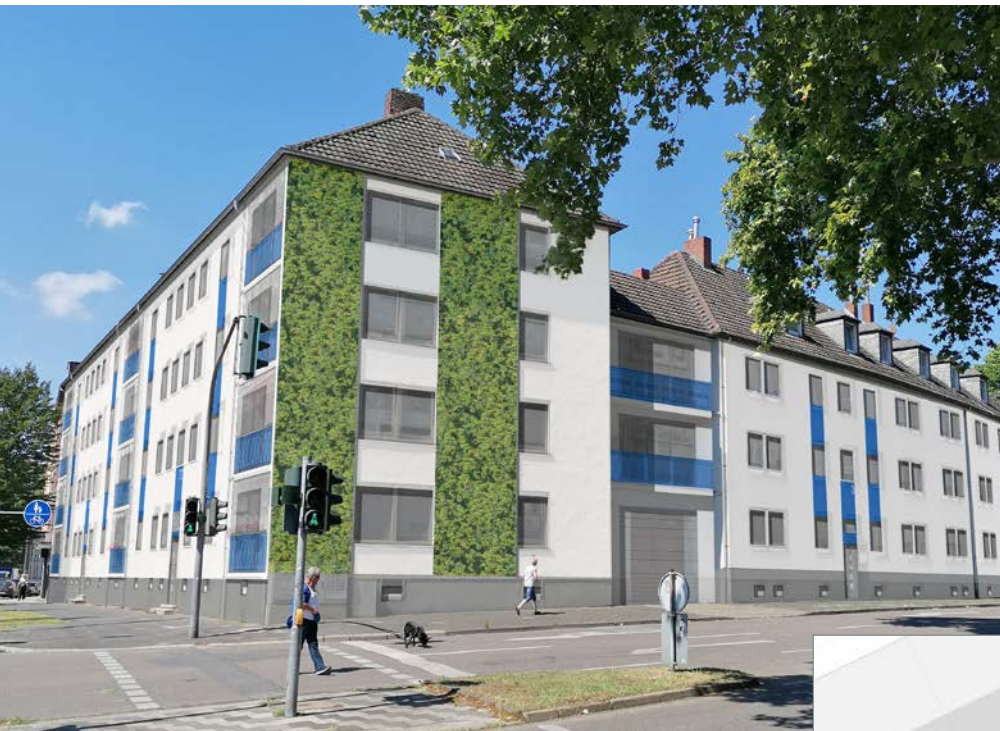
Fassadenbegrünung in der Feldmarkstraße
